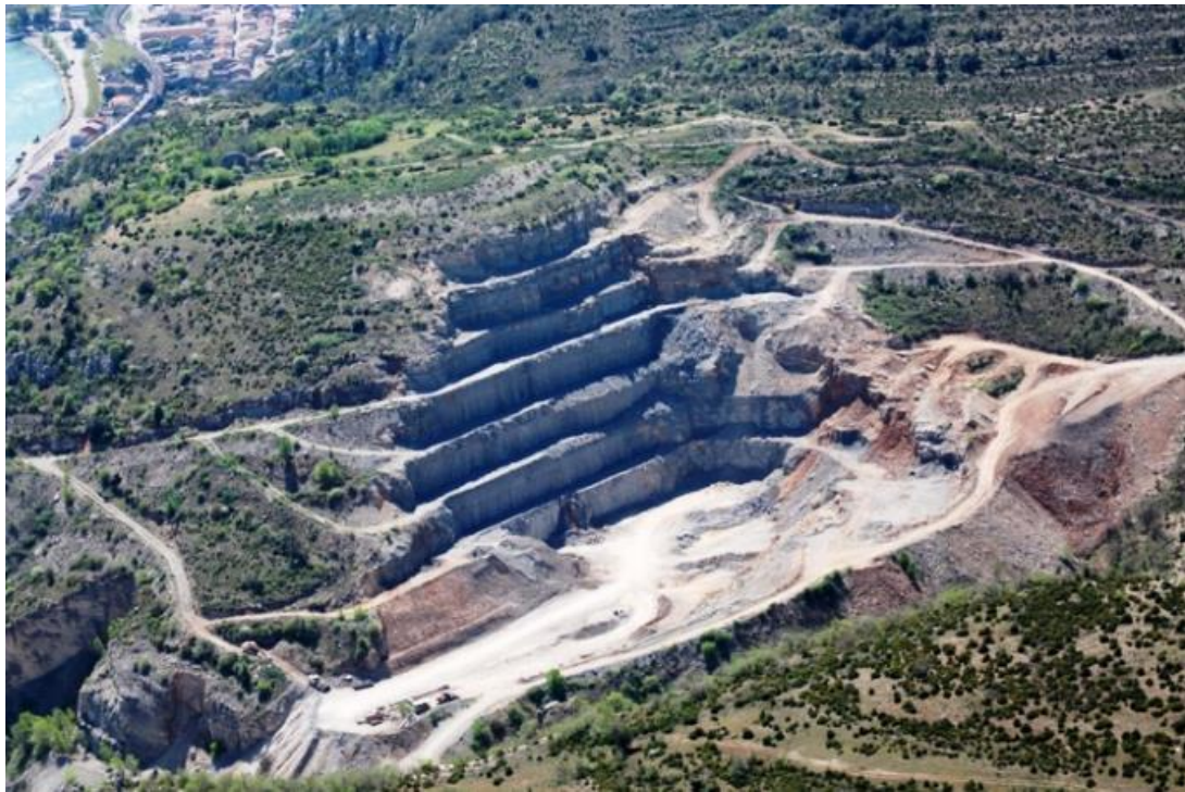
Figure 17: Carrière du Pouzin située sur un des versant du plateau de Rompon ( https://www.ar-deche-actu.com/ )
