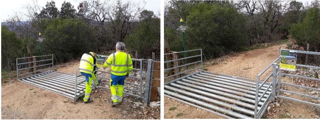
Photos 1 et 2 : Pose des panneaux d'information sur les portillons
